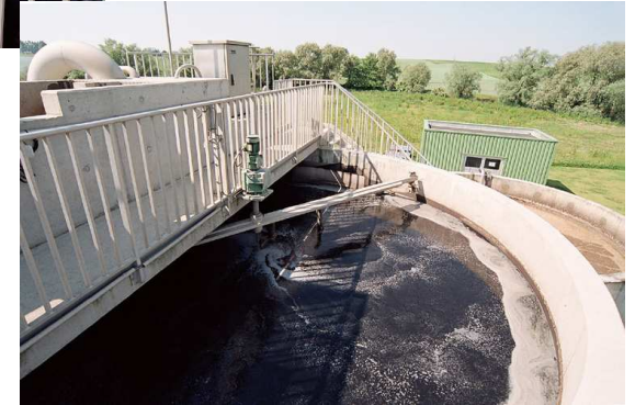
PRETRAITEMENTS DESSABLEUR DEGRAISSEUR
