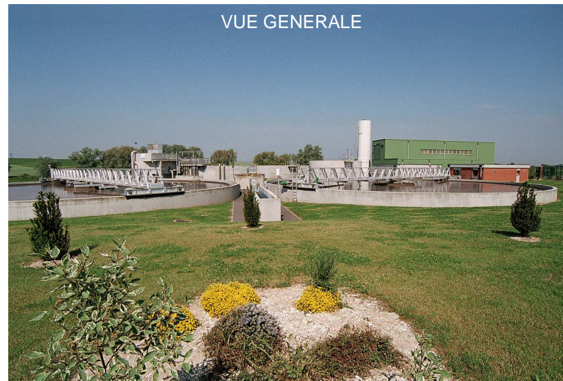
VUE GENERALE DES BASSINS BIOLOGIQUES
