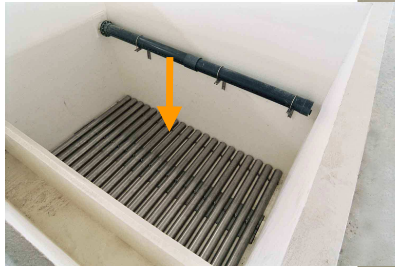
PLANCHER INOX avant mise en œuvre du massif filtrant
